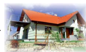
Dom z pompą ciepła
